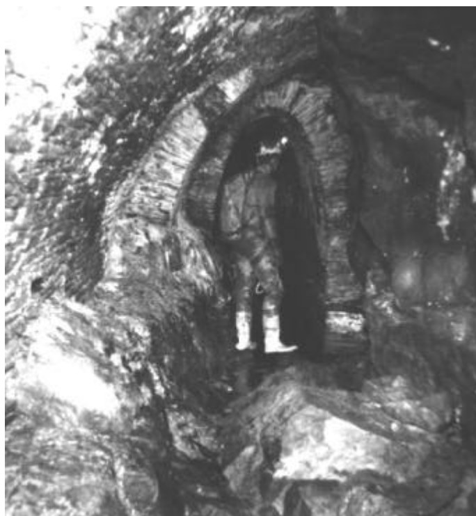
Abbildung 101: Gewölbe in einem Stolln
