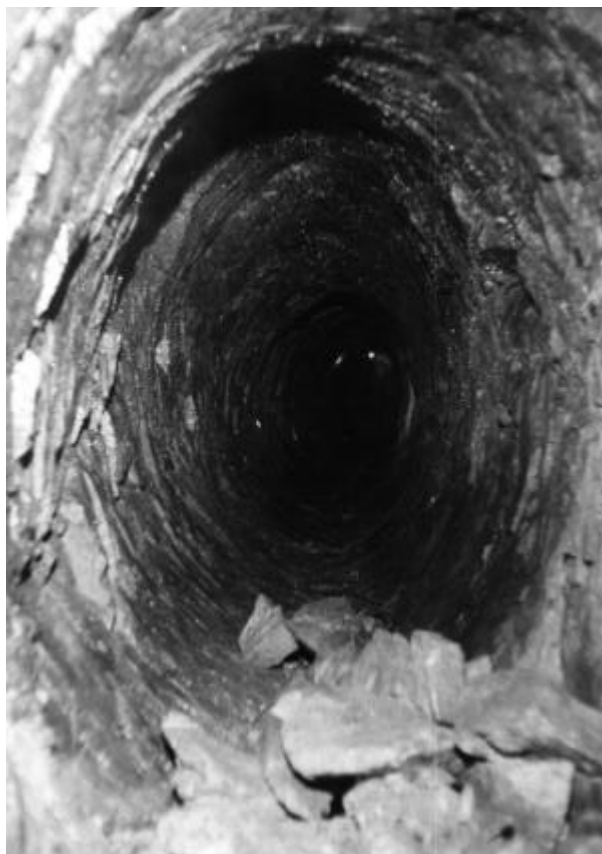
Abbildung 64: Feuergesetzte Strecke
