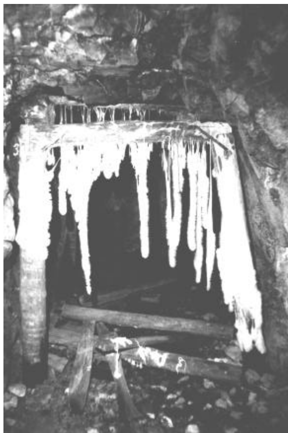
Abbildung 42: Pilzmyzelbehänge an einem Türstock Foto: privat
