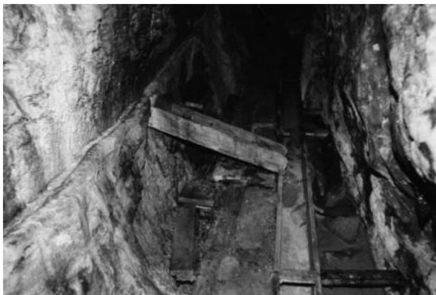
Abbildung 44: Ein Gefluderkasten fängt das in einem Gequelle gesammelte Wasser auf und leitet es in ein Gerinne
