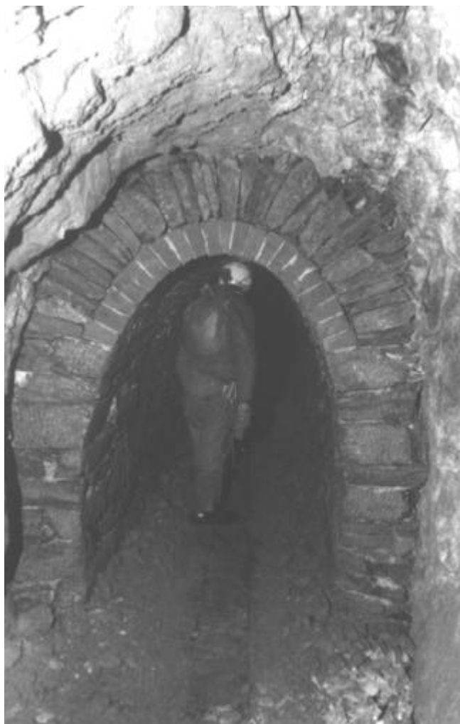
Abbildung 104: Kombination zwischen trocken gesetztem und Gewölbe mit Bindemittel Foto: privat
