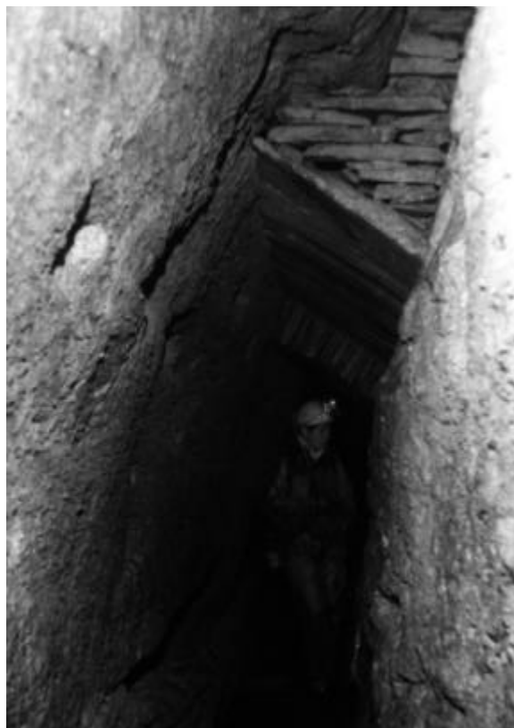
Abbildung 106: Ausbau mit Steinplatten Foto: privat
