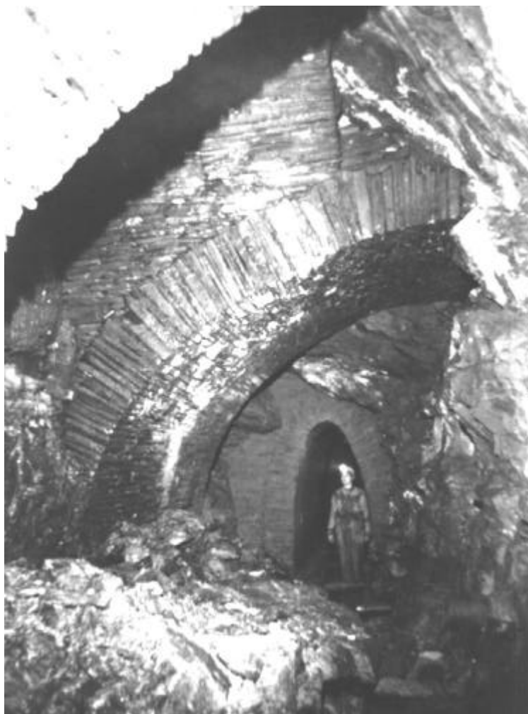
Abbildung 100: Trocken gesetztes Gewölbe mit überspringenden Bögen
