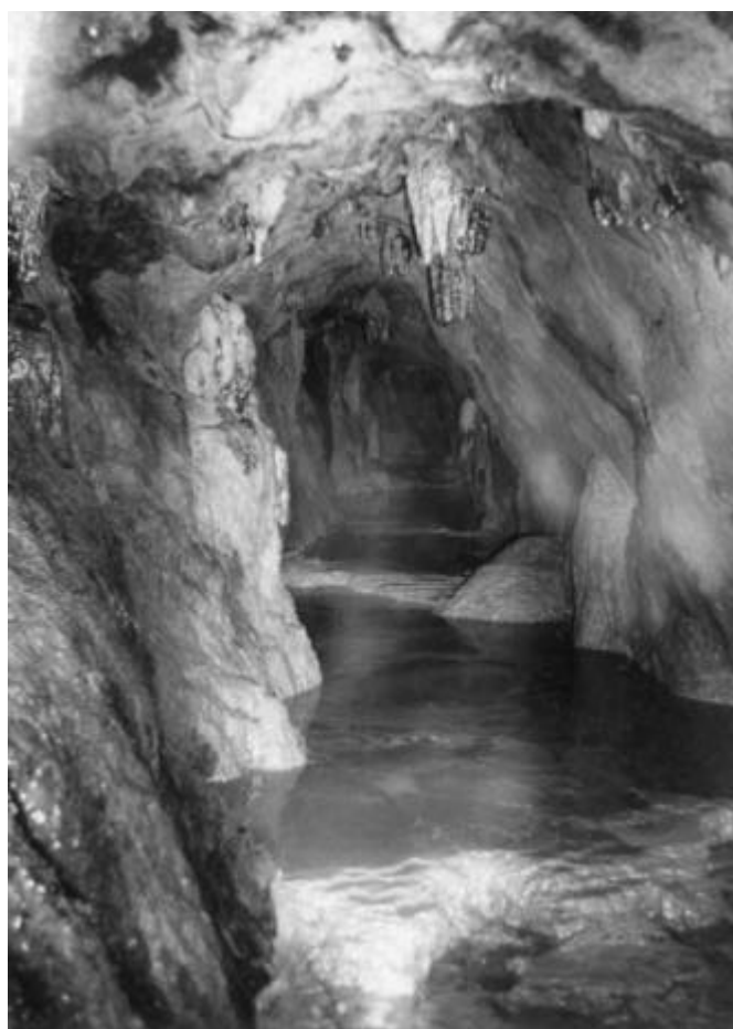
Abbildung 4: stark versinterte Strecke
