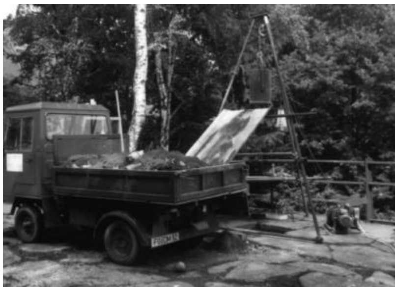
Abbildung 78: Entleeren von Förderkübeln I Kippbarer Kübel und verschiebbare Rutsche
