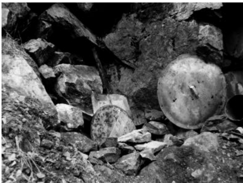
Abbildung 120: jenseits der DIN: „Befahrerverwahrung“ Foto: privat
