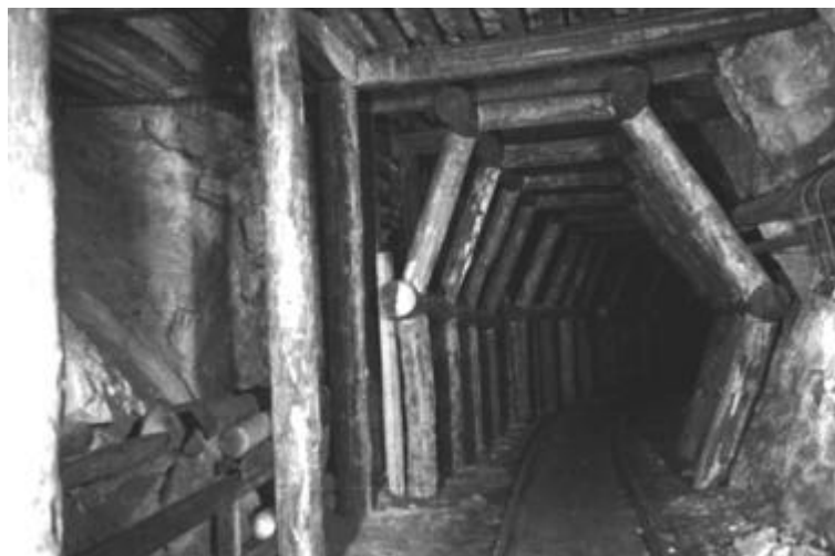
Abbildung 98: Ausgeführter Polygonausbau Reproduktion aus: [48]
