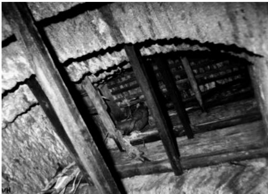
Abbildung 111: Schachtmauerung mit überspringenden Bögen Foto: privat Blick von unten nach oben im tonnlägigen Schacht mit Blick zum Liegenden
