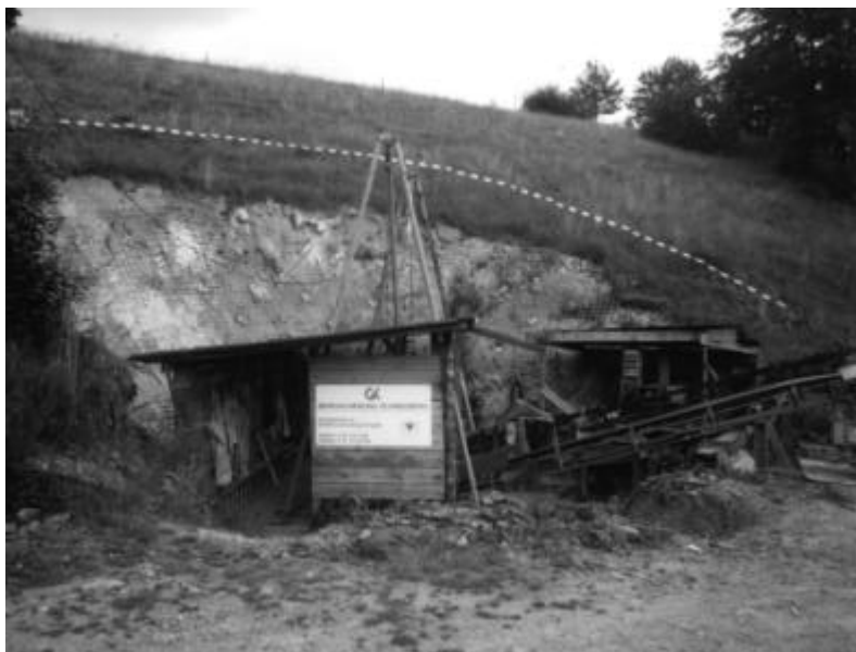
Abbildung 80: Baustelleneinrichtung einer größeren Schachtbaustelle
