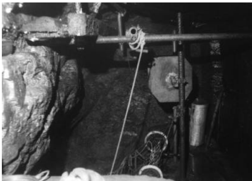
Abbildung 81: Skip und Haspel auf Befahrerbaustellen
